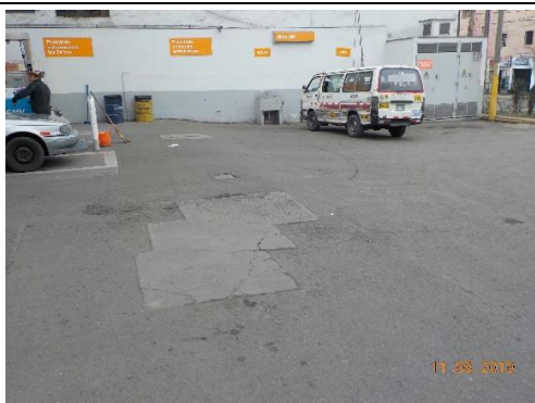
Fotografía 29 Losa zona patio de maniobras
