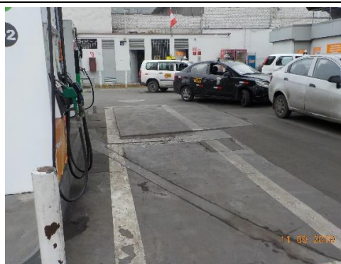
Fotografía 30 Losa zona islas
